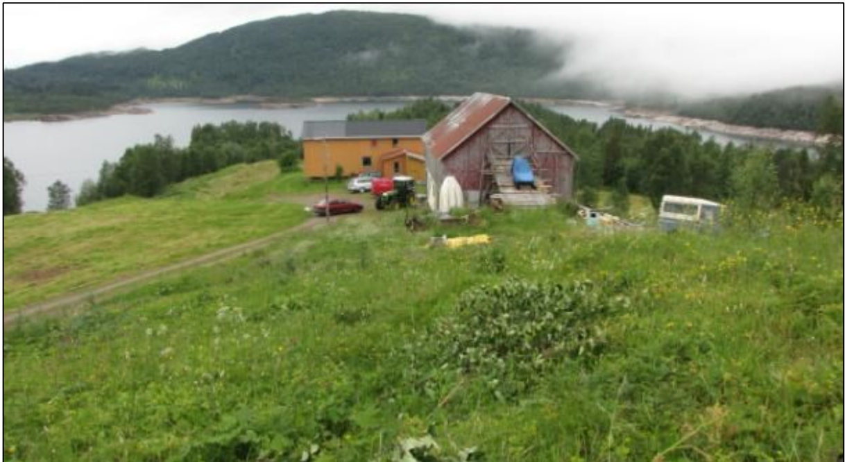
Hovedgården på Rapliåsen. Nærmest fotografen er en gammel beitebakke hvor det er påbegynt restaurering. Blant annet kan man se rester av ei bjørk som nylig er felt. Foto: Geir Arnesen.
